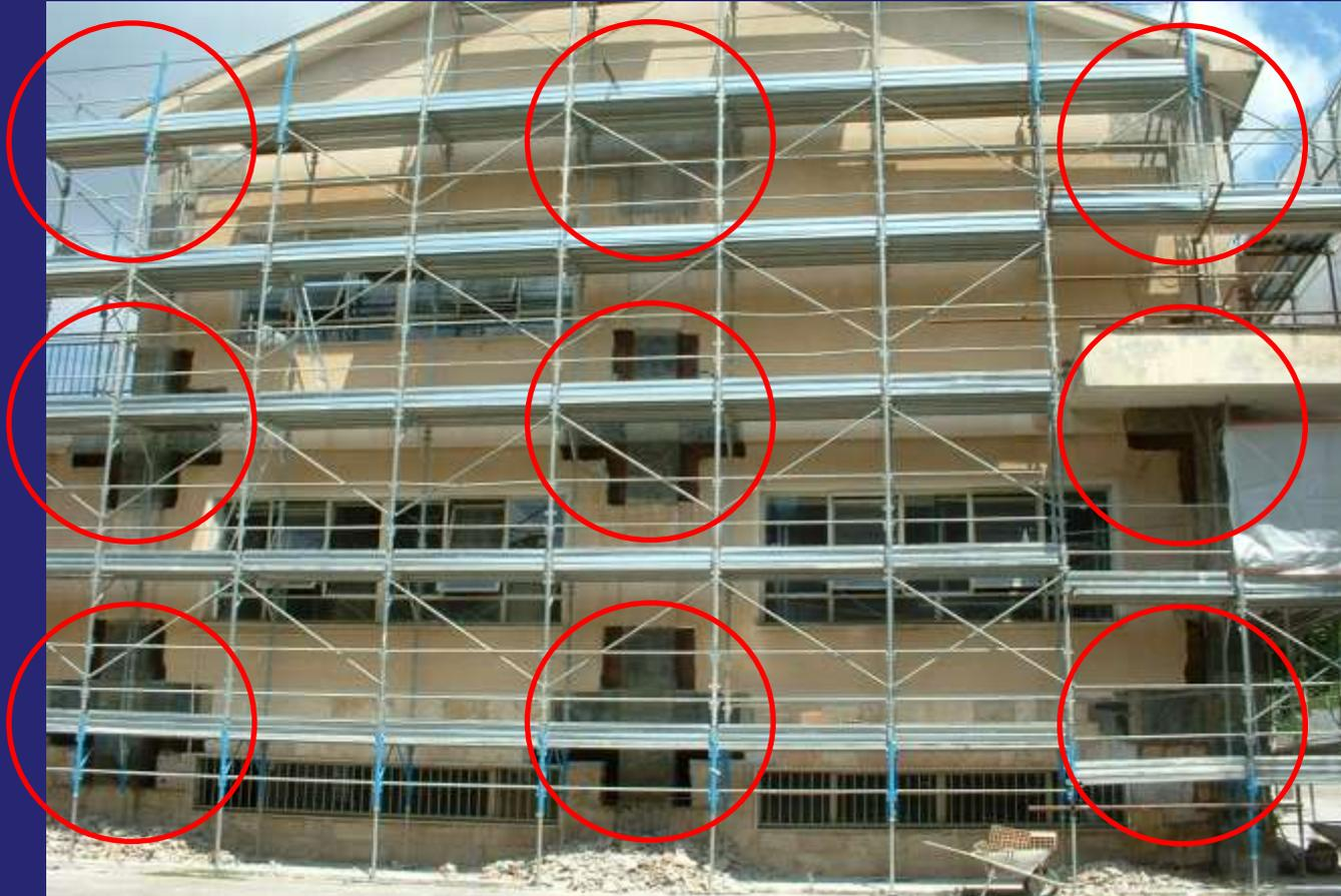
Interventi di rafforzamento locale che producono incrementi di massa e rigidezza strutturale trascurabili (quali FRP, ecc.), consentono di evitare ulteriori analisi globali, oltre a quella di valutazione dello stato di fatto.
