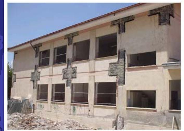
Rinforzo con FRP di un edificio in c.a. in scala reale
