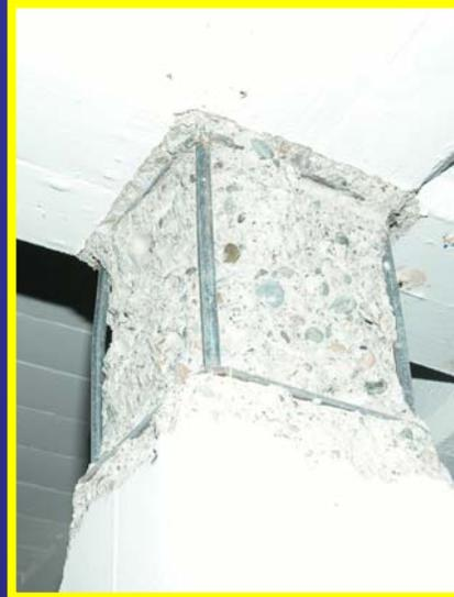
✓ Il rinforzo in FRP ha consentito alla struttura di sostenere azioni sismiche con ag amplificato di 1.5 in ambedue le direzioni senza subire danneggiamenti significativi
