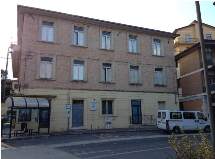
Edificio «moderno» (**anni '50**) in muratura regolare in mattoni con solai latero-cementizi non ben collegati alle pareti murarie parallele alle orditure. **Sono state disposte, dopo il terremoto del '97, catene scorrevoli in entrambe le direzioni all'ultimo livello, che hanno impedito meccanismi di ribaltamento con distacco dalla copertura.**
